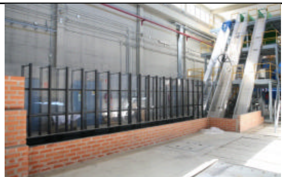
Instalación para experimentación de aireación forzada en aliviaderos y optimización de cuencos
